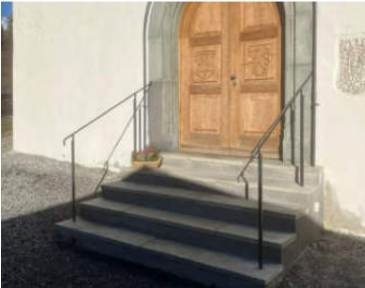
Neu hat es bei der Kirche Valendas beidseitig ein Geländer
